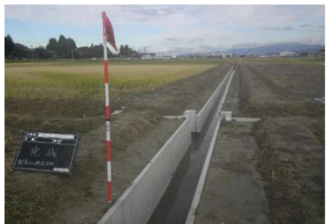
▲永光建設(株) 施工
