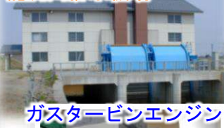
籠尻川排水機場
