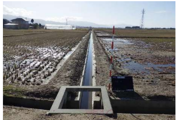
▲小菅建設興業(株) 施工
