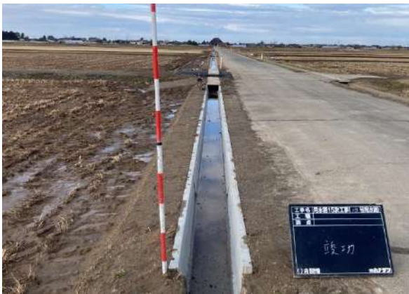
▲(株)ハナザワ 施工
