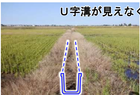
気温が上がる6月ごろから幹線・支線の用水路に藻が発生し通水の障害となっています。
