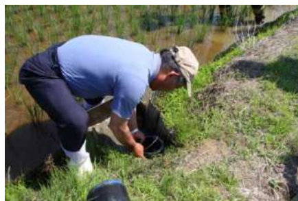
「田んぼダム」調整管設置
