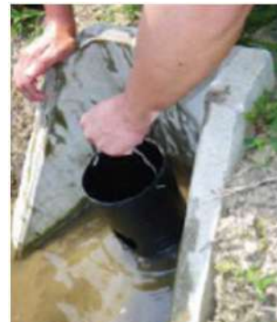
降雨前に調整管を上げる (フリードレーン横穴方式)
