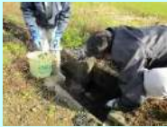
水路目地補修
