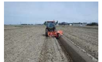
漏水防止のための畦塗り
